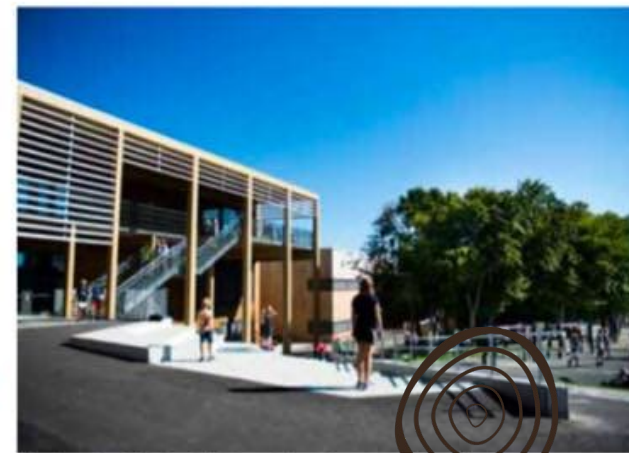
Åsveien skole i Trondheim er blant byggene i Trondheim som er oppført i massivtre. FOTO: TRONDHEIM KOMMUNE
